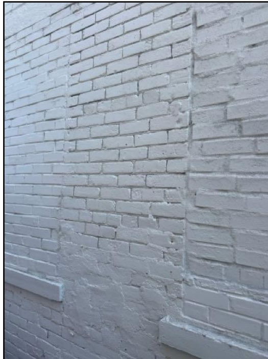
17. Mortar deterioration
